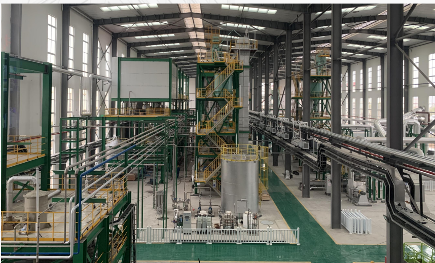
CKB锂电池回收利用项目实景
