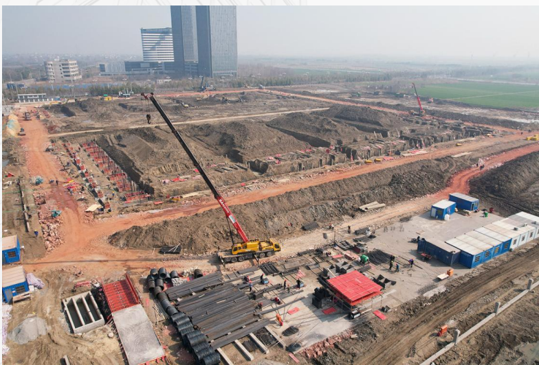
正极材料项目现场建设图
